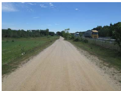
Figura 6. Capa de rodadura de tot-ú
