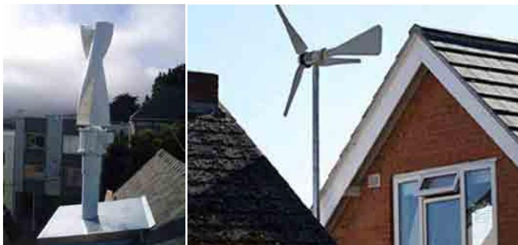
Figura 34: Ejemplos de generador mini eólico de eje vertical (izquierda) y de eje horizontal (derecha) integrados en tejados. Fuente: Eneris
