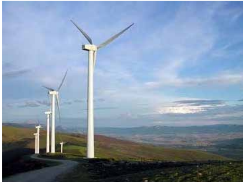
Figura 32: Vista del parque eólico de Elgea-Urkilla
