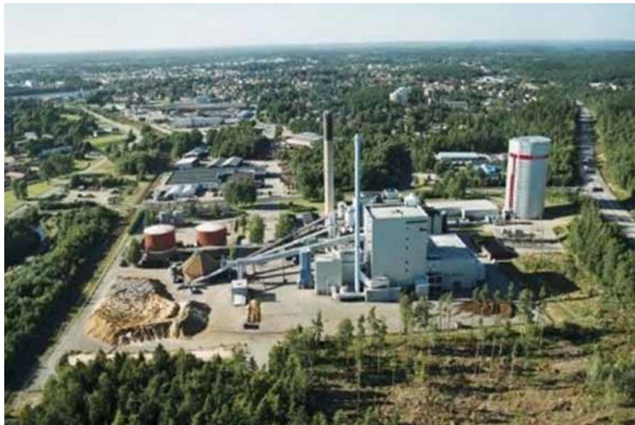
Figura 38: imagen de la planta de cogeneración de calor y electricidad por biomasa en Vaxjo (Suècia) Fuente: CTT (Centro de Transferencia Tecnológica de la Madera)
