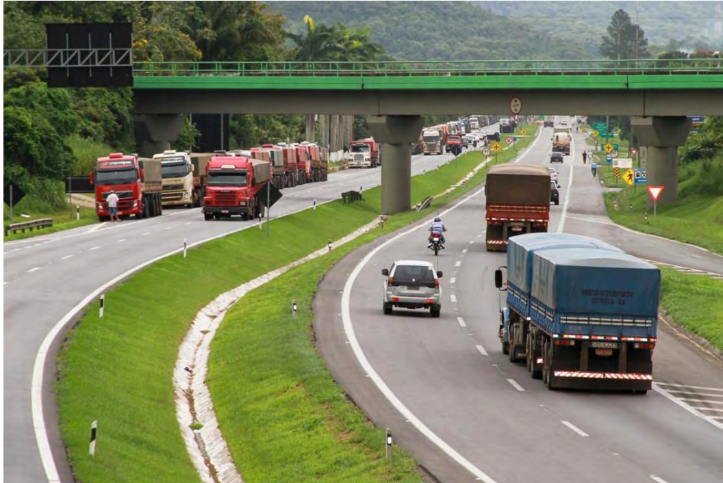
Figura 144. Filas na BR-277 no acesso ao Porto de Paranaguá
