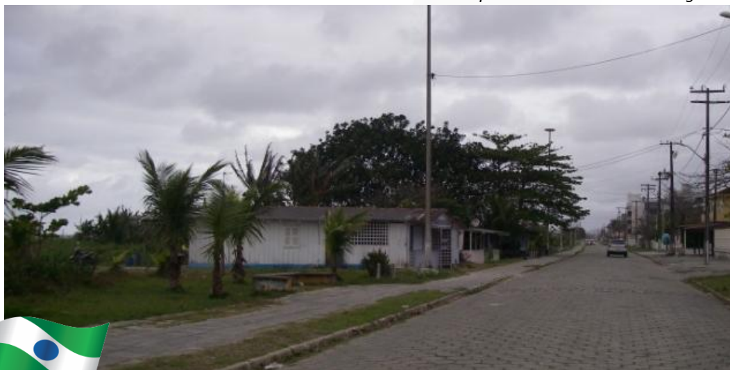
Edificação irregular em área de Restinga
