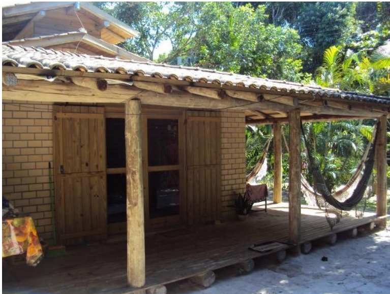
Instalações locadas para alojamento de Bombeiros na Ilha do Mel
