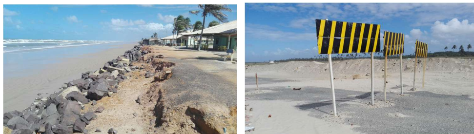
Imagem 36. Erosão costeira observada no litoral Sul do Estado de Sergipe. Fonte: Elaboração própria, 2017.
