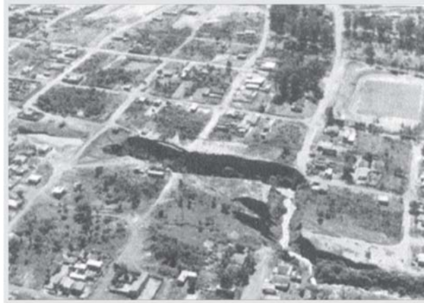
Figura 2.7 erosão do solo devido ao aumento da velocidade da água pelos condutos e áreas impermeáveis.
