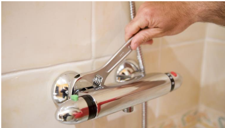
Ilustración 56: Instalación grifo termostático (Fuente: Leroy Merlin)
