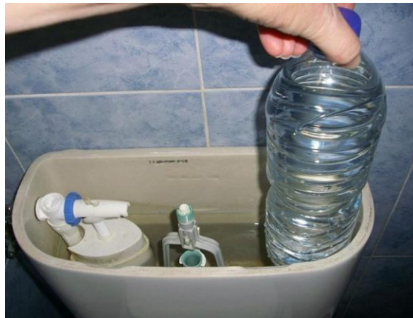
Ilustración 53: Reducción de la descarga del inodoro
