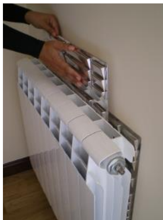
Ilustración 25: Colocación de lámina reflectante tras radiador
