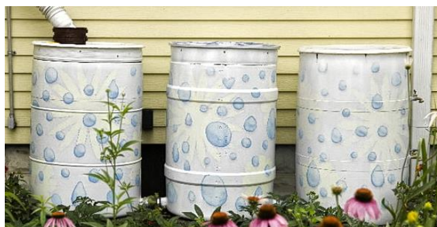
Ilustración 58: Barriles captadores de agua pluvial
